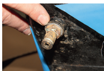
...schrauben wir einen Adapter als Auslauf mit Verschlusskappe ein
