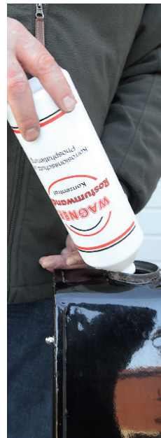
Stark konzentriert (1:1) erzeugt Rostumwandler am Ende eine schützende Phosphatschicht
